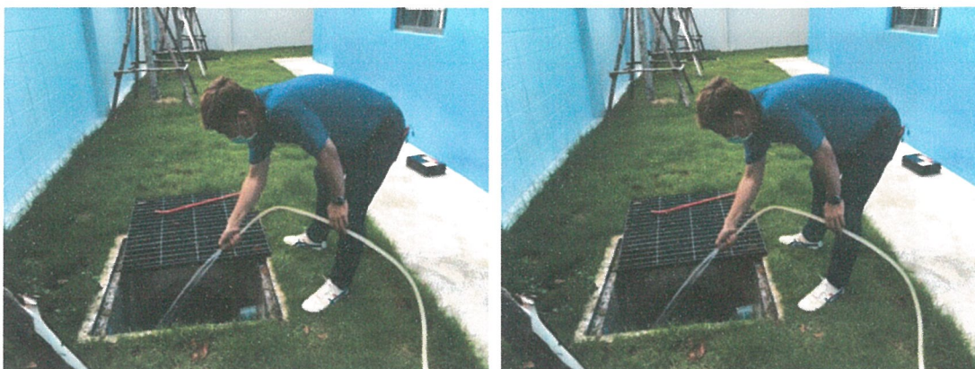
รูปภาพที่ 2.48 การขุดลอกตะกอนในรางระบายน้ำ
