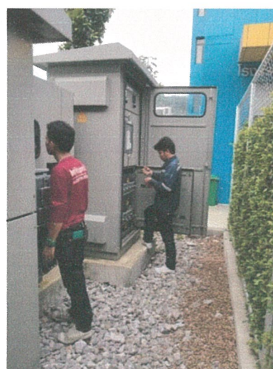
รูปภาพที่ 2.54 การตรวจสอบหม้อแปลงไฟฟ้า
