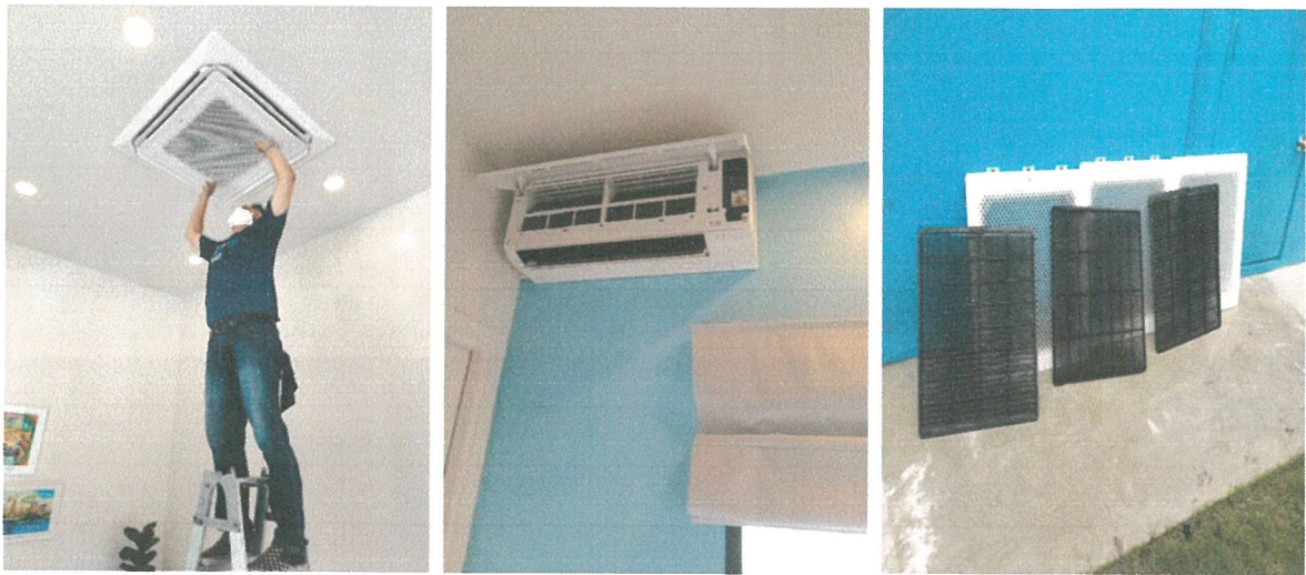
รูปภาพที่ 2.33 การล้างทำความสะอาดเครื่องปรับอากาศ
