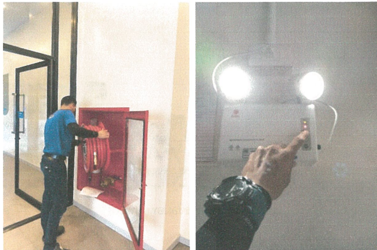
รูปภาพที่ 2.55 การตรวจสอบอุปกรณ์ป้องกันอัคคีภัย
