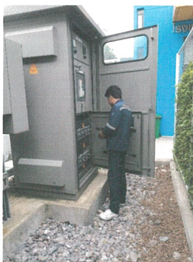
รูปภาพที่ 2.54 การตรวจสอบหม้อแปลงไฟฟ้า
